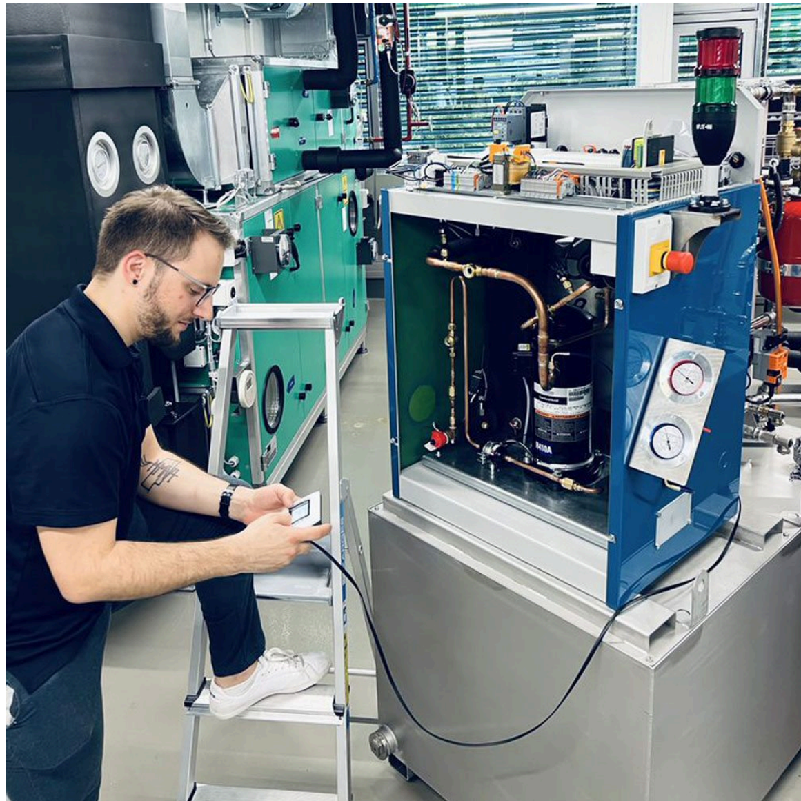
De nouvelles pompes à chaleur pour s'entraîner à la STFW
